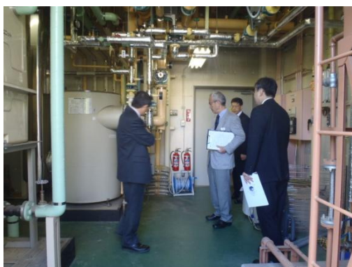
現場確認の様子
